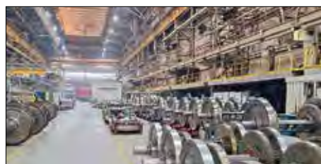
Освещение производственных цехов ООО «Уральские локомотивы» стр. 327
